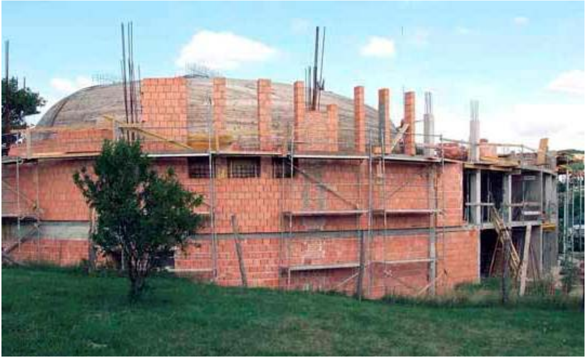
Római katolikus templom épül
